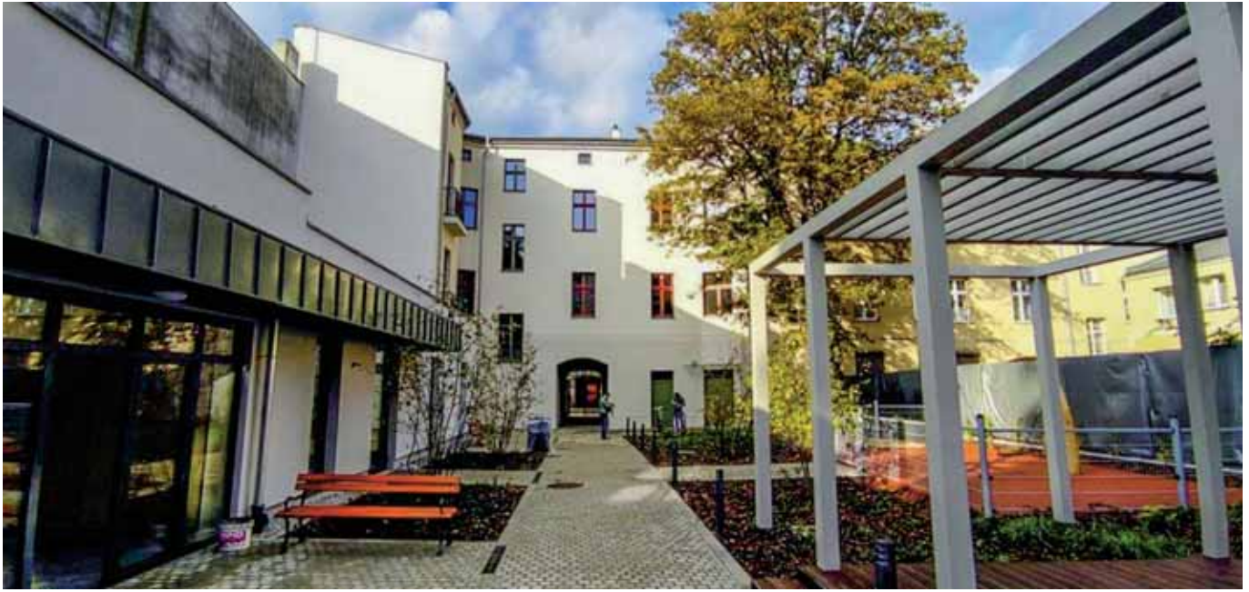
Zrewitalizowana posesja przy ul. Wschodniej 42
