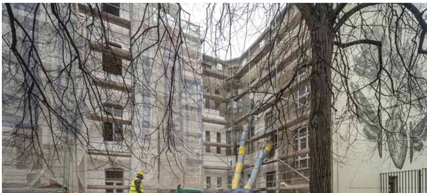
Rewitalizacja kamienicy przy. ul. Kilińskiego 26
