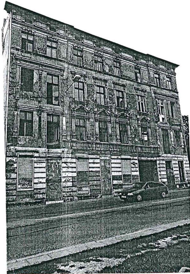
Widok elewacji wschodniej
