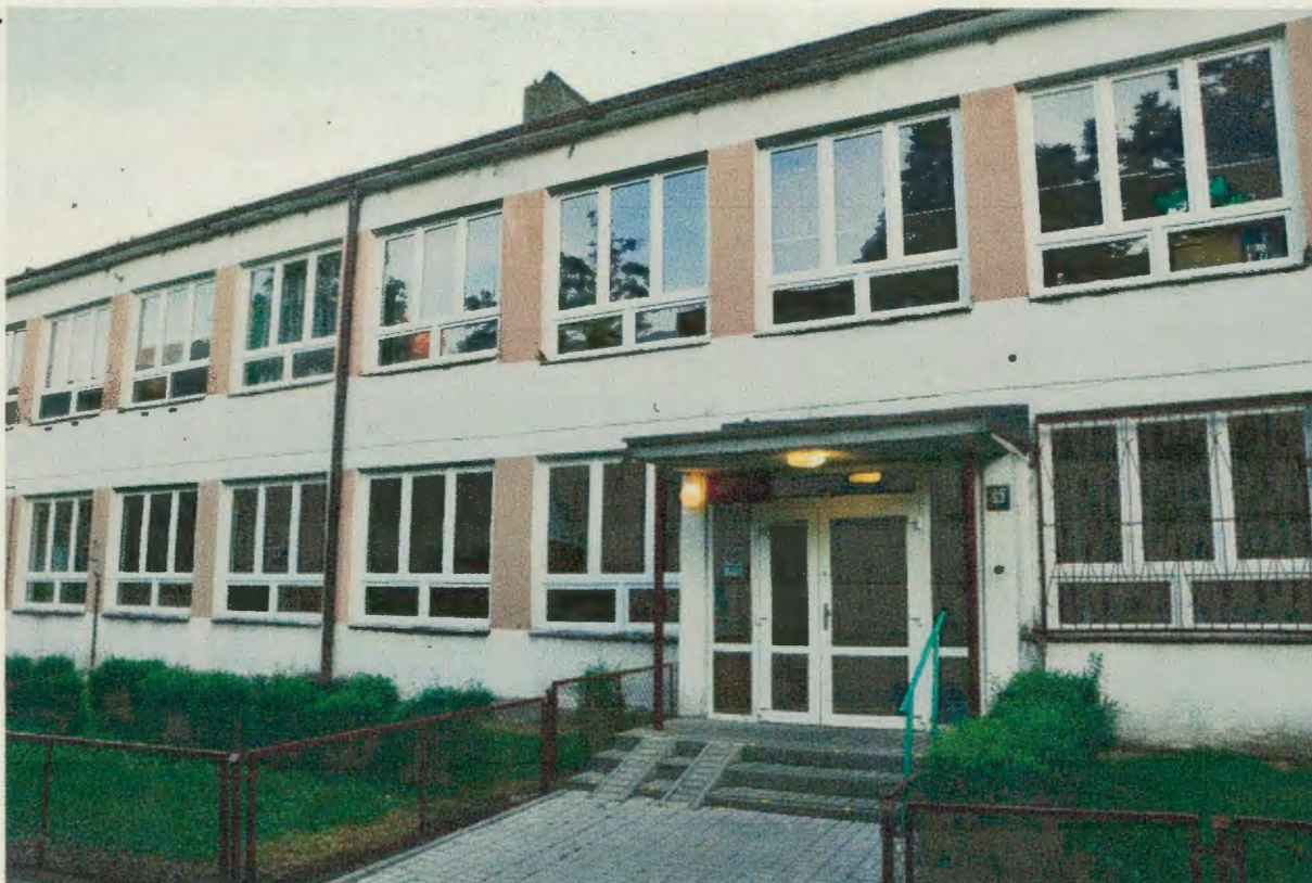
Fot. 1. Elewacja z wejściem do budynku, pod stropem otwory - miejsce lęgów ptaków.
