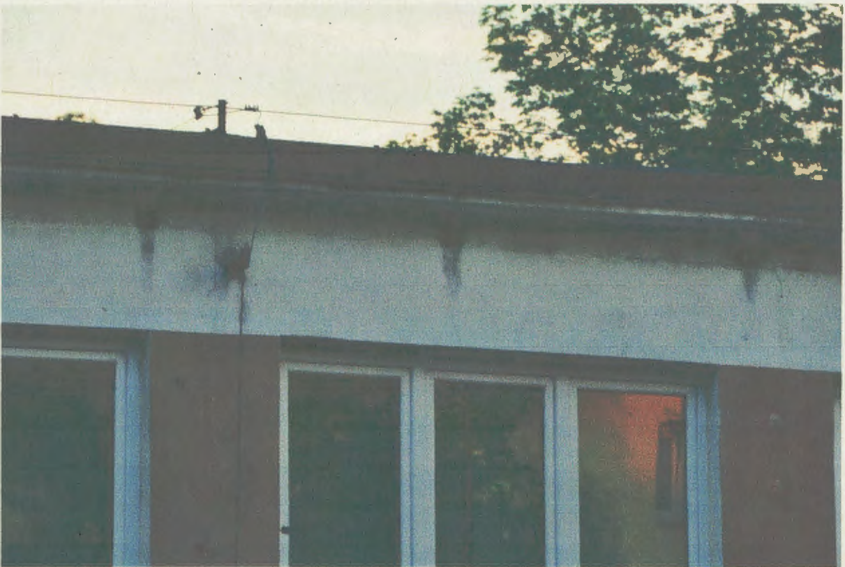
Fot. 8. Elewacja od strony placu zabaw, pod stropem otwory - miejsce lęgów ptaków, widoczne zabrudzenia elewacji przez siadające ptaki.
