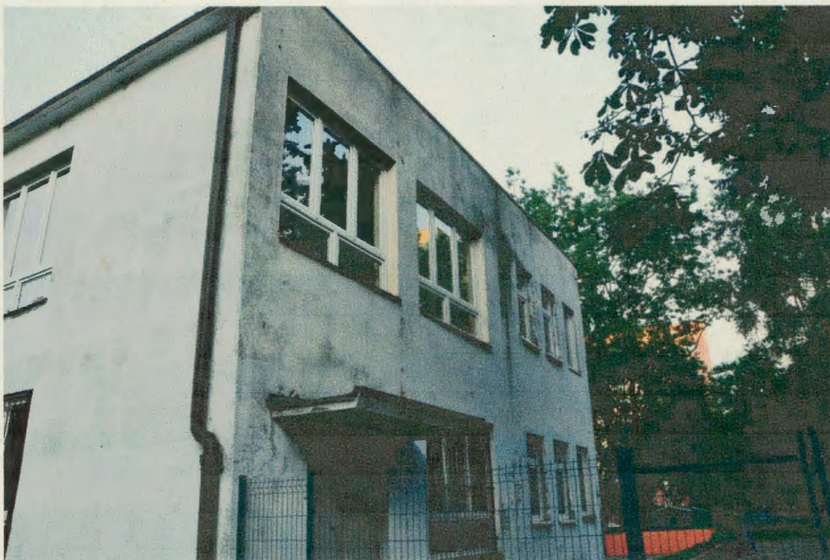
Fot. 2. Elewacja z wejściem do budynku otwory pod stropem, w których gniazdują ptaki. Ściana szczytowa zachodnia, brak siedlisk rozrodu ptaków.
