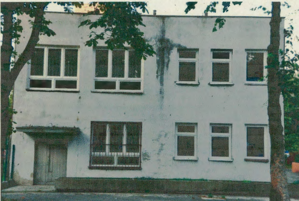
Fot. 6. Ściana szczytowa zachodnia - brak siedlisk rozrodu ptaków.
