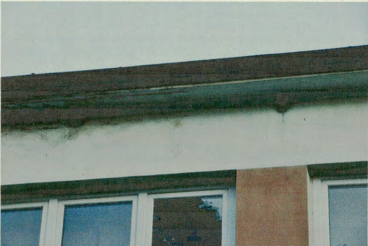
Fot. 4. Elewacja z wejściem do budynku, pod stropem otwory - miejsce lęgów ptaków.
