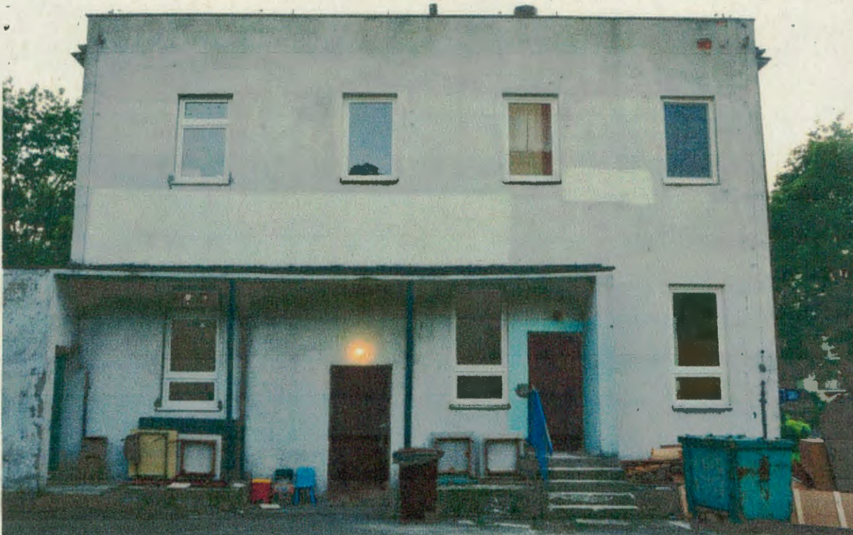
Fot. 5. Ściana szczytowa wschodnia (od ul. Jachowicza) - brak siedlisk rozrodu ptaków.
