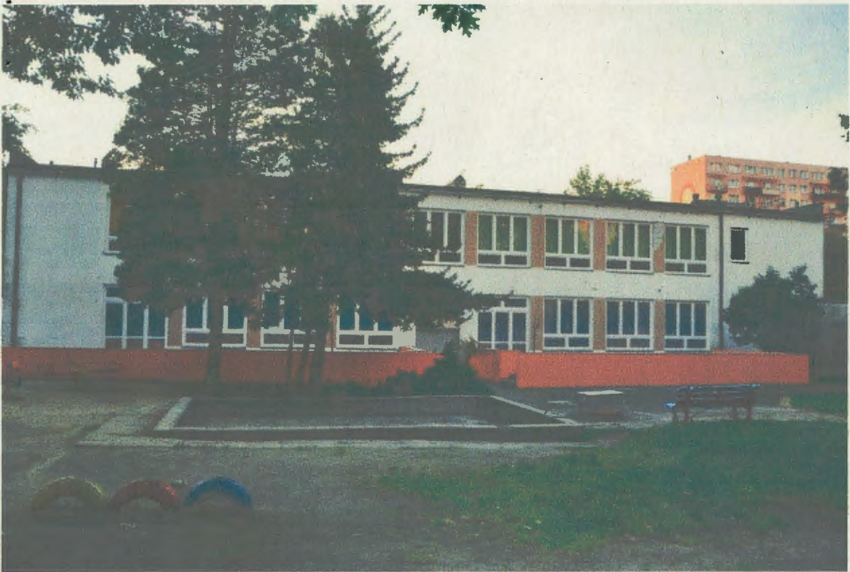
Fot. 7. Elewacja od strony placu zabaw, pod stropem otwory - miejsce lęgów ptaków.
