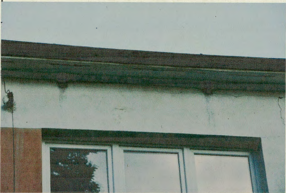
Fot. 3. Elewacja z wejściem do budynku, pod stropem otwory - miejsce lęgów ptaków.
