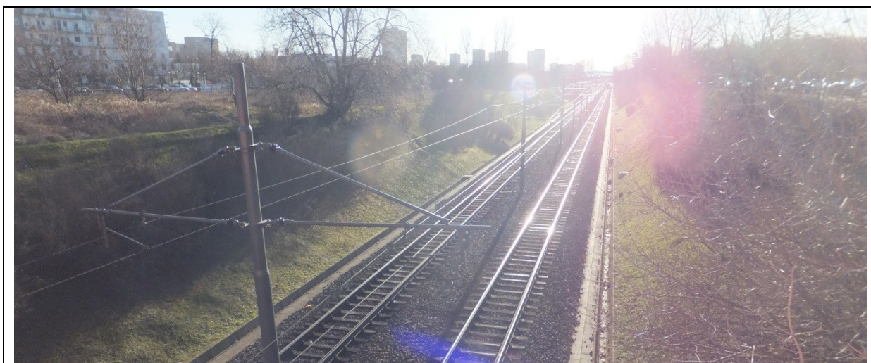
Rys. 46 Wały ziemne wzdłuż linii tramwajowej; torowisko zlokalizowane jest poniżej poziomu terenu na którym znajduje się zabudowa mieszkaniowa (materiały własne)
