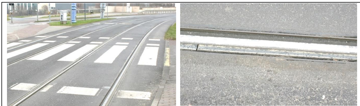
Rys. 34 Torowisko w jezdni z systemem tłumiącym ORTEC (materiały własne)
