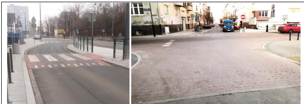
Rys. 22 Wyniesione przejście dla pieszych oraz wyniesione skrzyżowanie (materiały własne)
