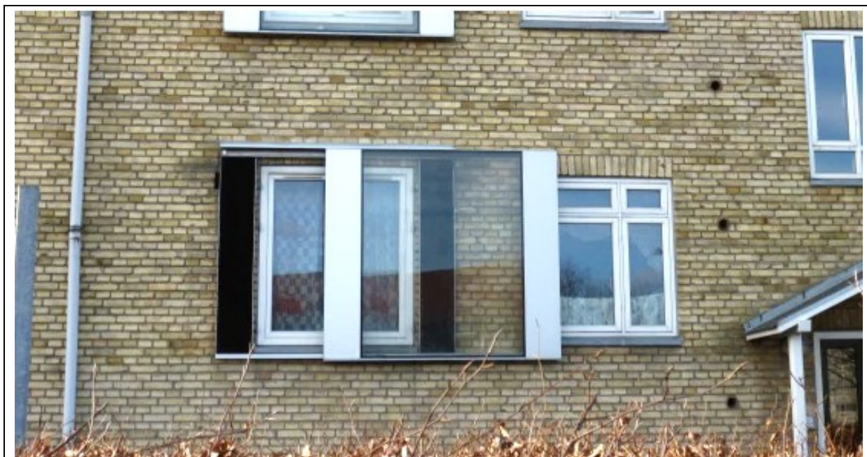
Rys. 51 Dodatkowa, ruchoma elewacja szklana zamontowana przed oknem pomieszczenia mieszkalnego, pozostawiając możliwość otwarcia okna (źródło: CEDR Call 2012: Noise; ON-AIR Optimised Noise Assessment and Management Guidance for National Roads; Investigation of noise planning procedures and tools, 2015)
