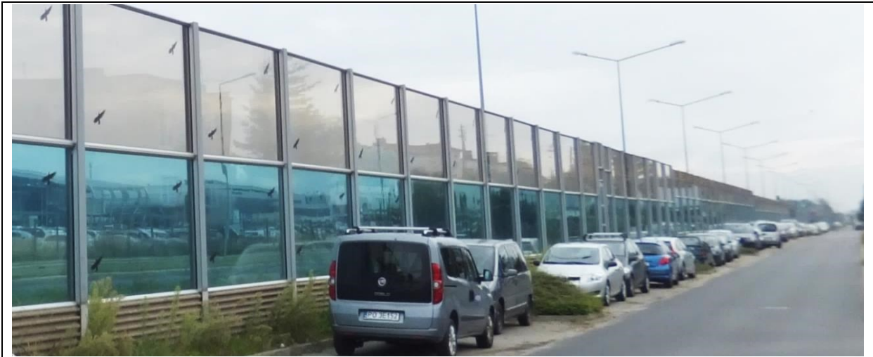
Rys. 38 Ekran przeciwhałasowy odbijający zbudowany z szkła akrylowego i keramzytobetonu u podstawy (materiały własne)
