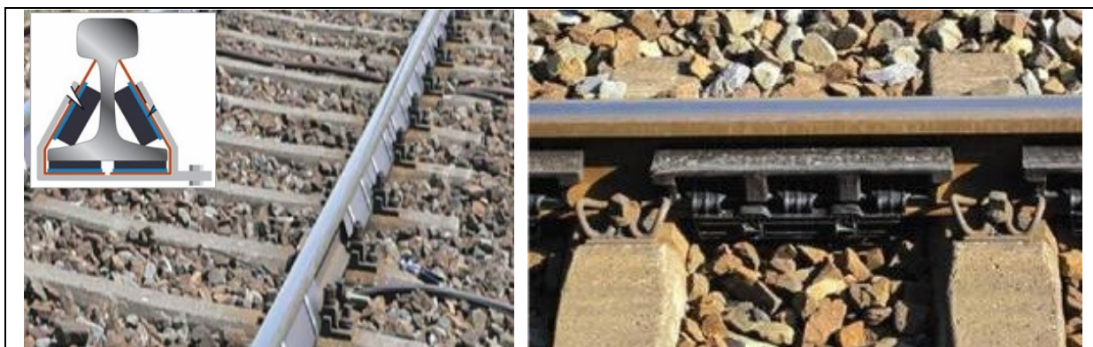
Rys. 33 Absorbery wibroizolacyjne (źródło: DB Netze: Innovative Maßnahmen zum Lärm- und Erschütterungsschutz am Fahrweg, Schlussbericht, 15.06 2012)
