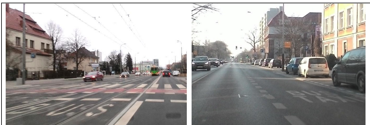
Rys. 19 Drogi rowerowe, buspasy, wydzielone torowisko w jezdni, redukcja pasów ruchu dla pojazdów osobowych do jednego na kierunek (materiały własne)
