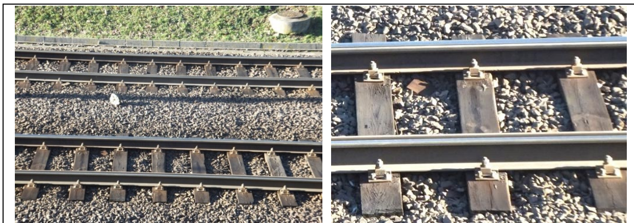
Rys. 30 Torowisko tramwajowe o sztywnym mocowaniu szyn bezстыkowych, podkładach drewnianych i podsypce (materiały własne)
