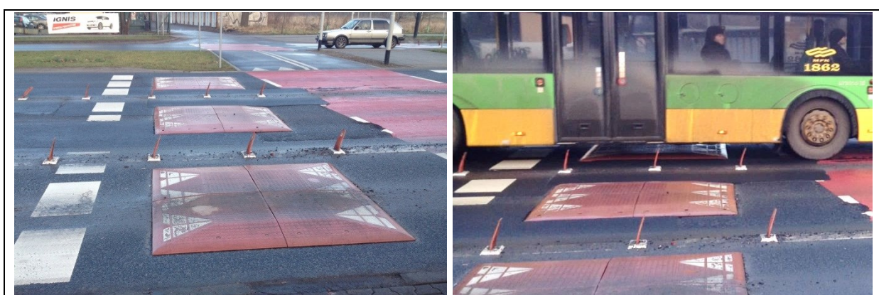
Rys. 23 Poduszki berlińskie - specjalny próg spowalniający ruch pojazdów osobowych. Poduszki berlińskie są wąskimi wyniesieniami, umożliwiającymi niezakłócony przejazd pojazdom ciężkim np. autobusom komunikacji miejskiej - rozstaw kół jest szerszy niż wymiar poduszki (materiały własne)
