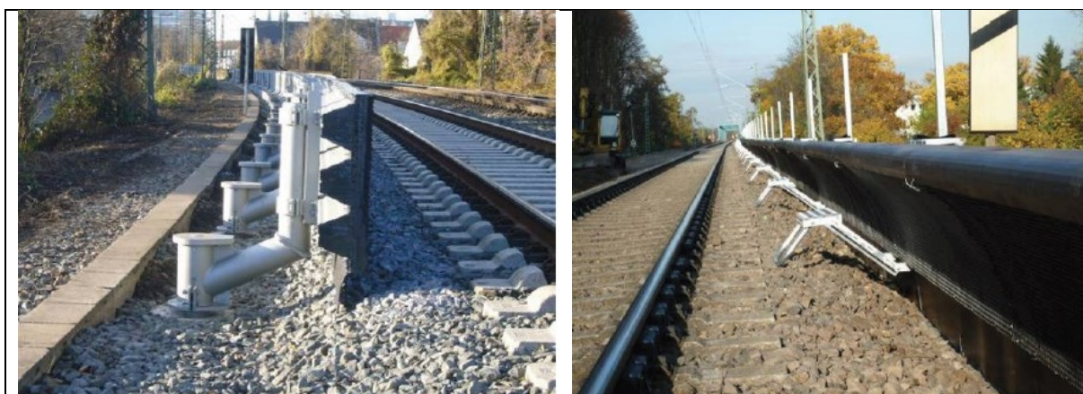
Rys. 44 Niski ekran przeciwhałasowy, nieodchylany (źródło: DB Netze: Innovative Maßnahmen zum Lärm- und Erschütterungsschutz am Fahrweg, Schlussbericht, 2012)
