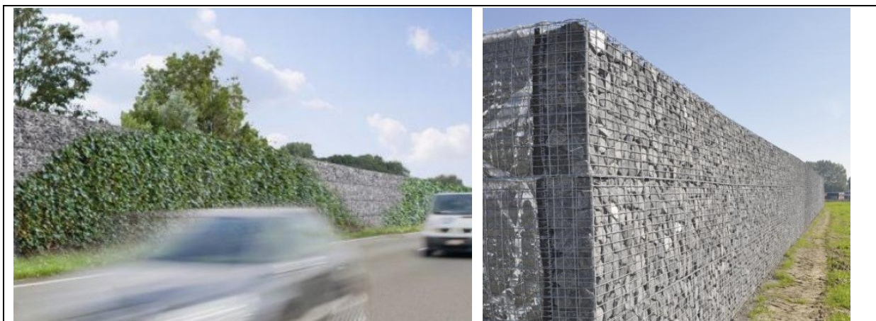
Rys. 45 Ekran akustyczny zbudowany z gabionów porośnięte roślinnością (źródło: Soundblock, Betafence: https://www.betafence.pl/pl/soundblock-0 )
