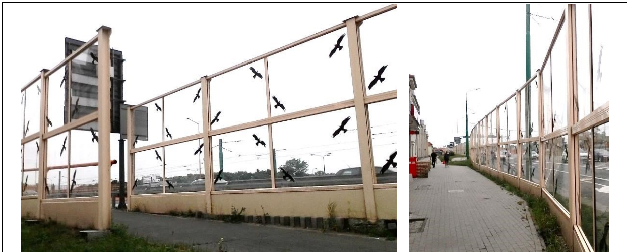
Rys. 39 Przezierny ekran przeciwhałasowy odbijający (na zakładkę) w pobliżu zabudowy mieszkaniowej (materiały własne)
