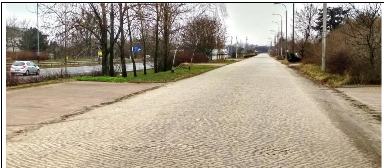
Rys. 28 Przykład drogi o nawierzchni z kostki brukowej. Emisja hałasu pojazdu poruszającego się po tego rodzaju nawierzchni jest większa o ok. 3 dB względem ruchu na asfaltobetonie przy zachowaniu tej samej prędkości (dane na podstawie NMPB-Routes-08, zdjęcie – materiały własne)
