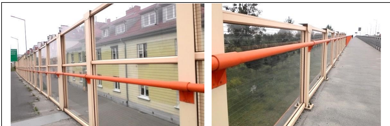
Rys. 40 Przezierny ekran przeciwhałasowy odbijający o lekkiej konstrukcji na wiadukcie (materiały własne)
