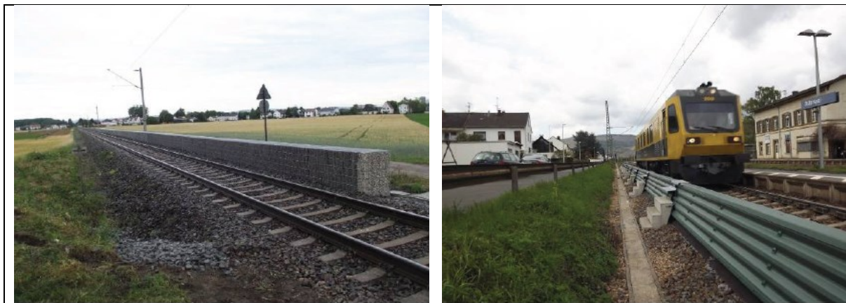
Rys. 43 Niski ekran przeciwhałasowy (wysokość 0,75 m) (źródło: DB Netze: Innovative Maßnahmen zum Lärm- und Erschütterungsschutz am Fahrweg, Schlussbericht, 2012)
