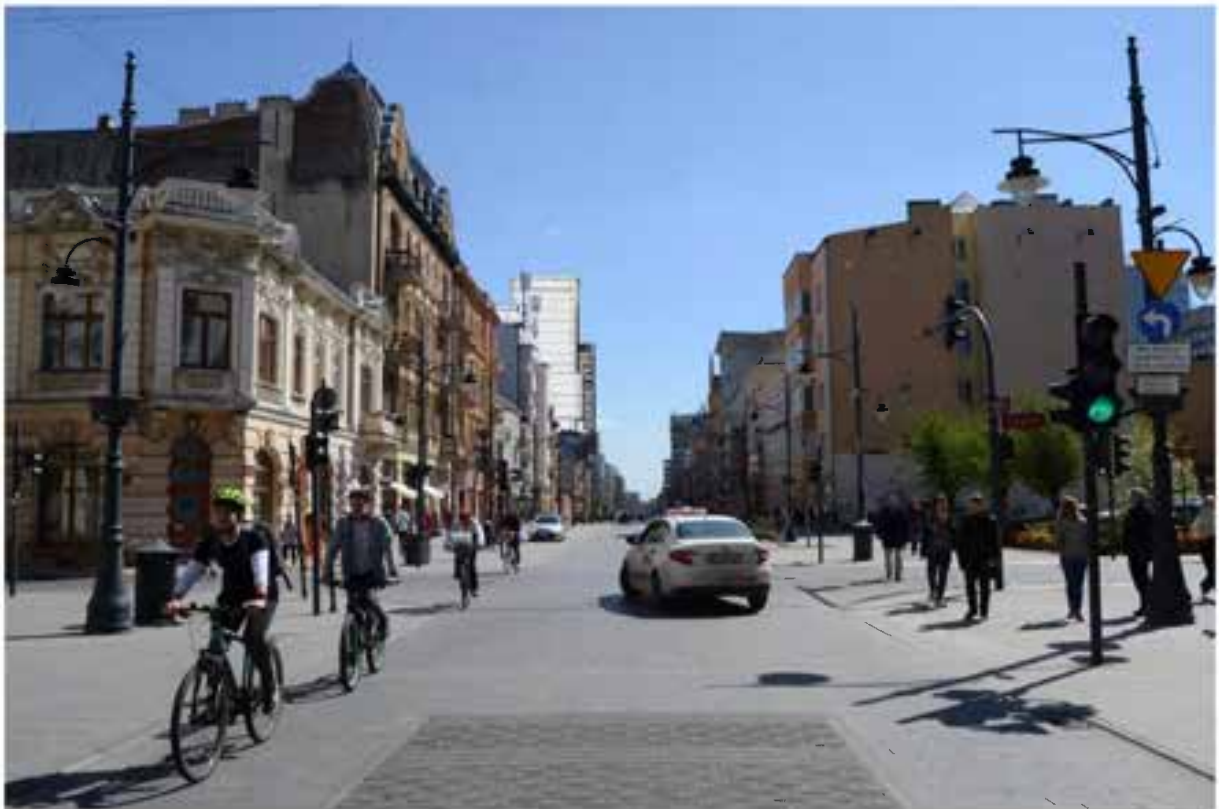
Widok | Skrzyżowanie ul. Piotrkowskiej oraz Zamenhofska w kierunku południowym
