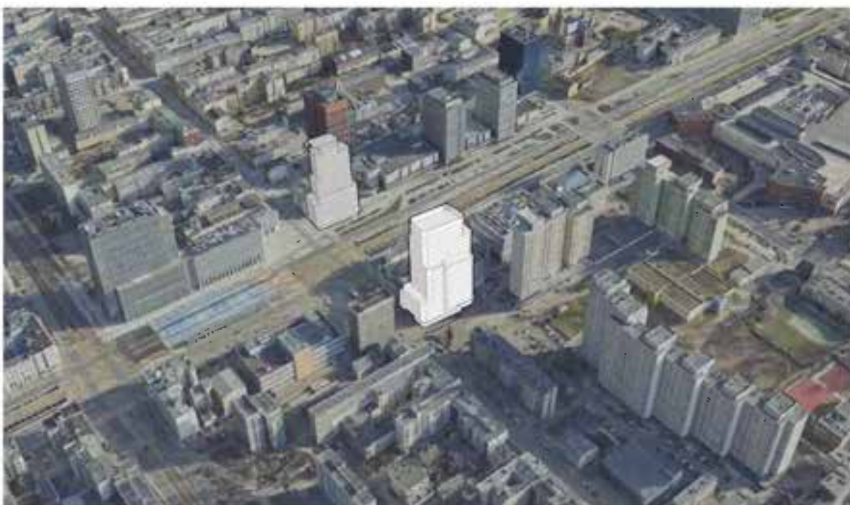
Widok z lotu ptaka w kierunku północno-wschodnim
