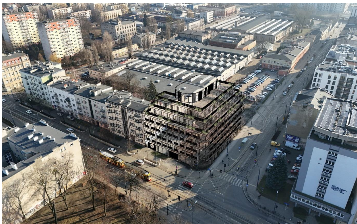
Widok z lotu ptaka w kierunku południowo-wschodnim
