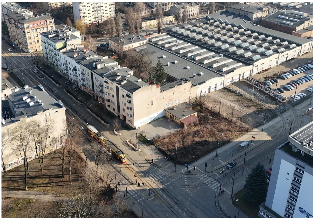
Widok od strony północno-zachodniej
