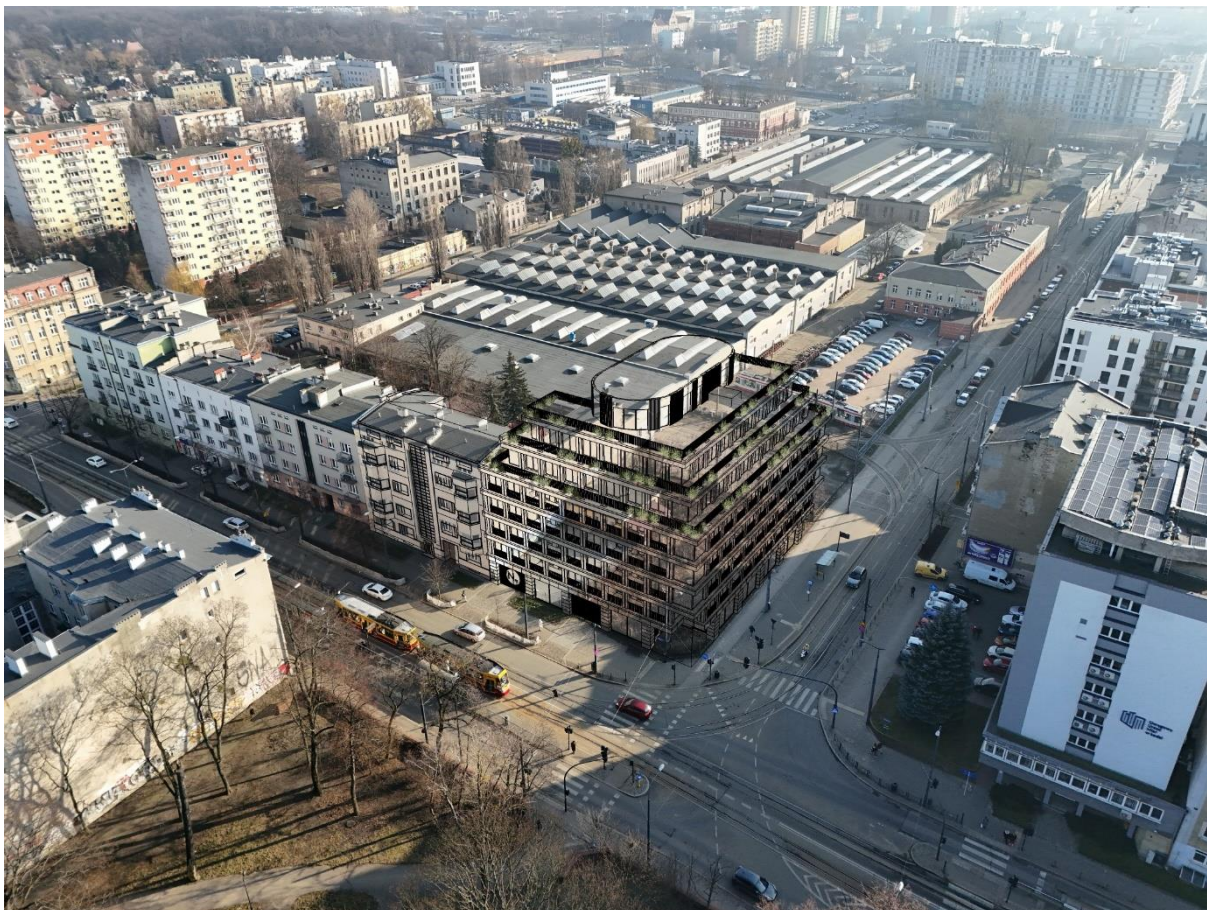
Widok z lotu ptaka w kierunku południowo-wschodnim
