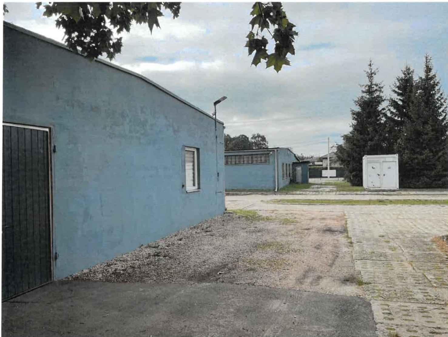
Fot. 1 Widok ze środka inwestycji, od strony południowej w stronę ul. Gajcego
