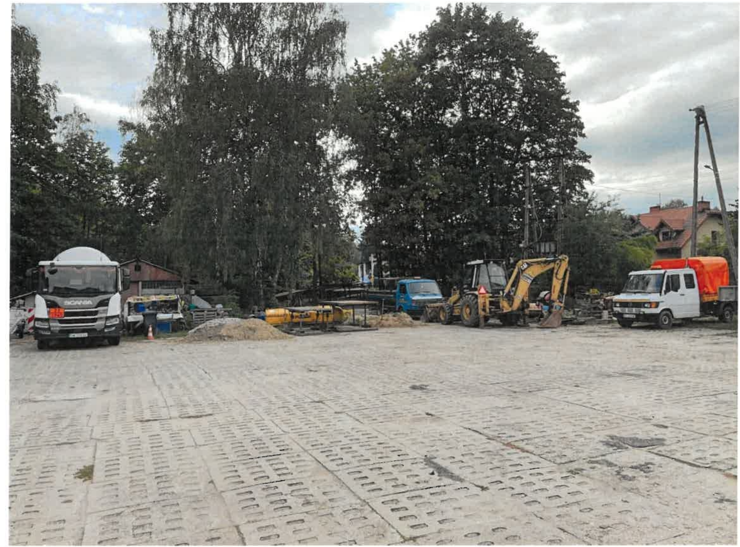
Fot. 2 Widok ze środka inwestycji, w stronę terenu zieleni, od ul. Przylesie
