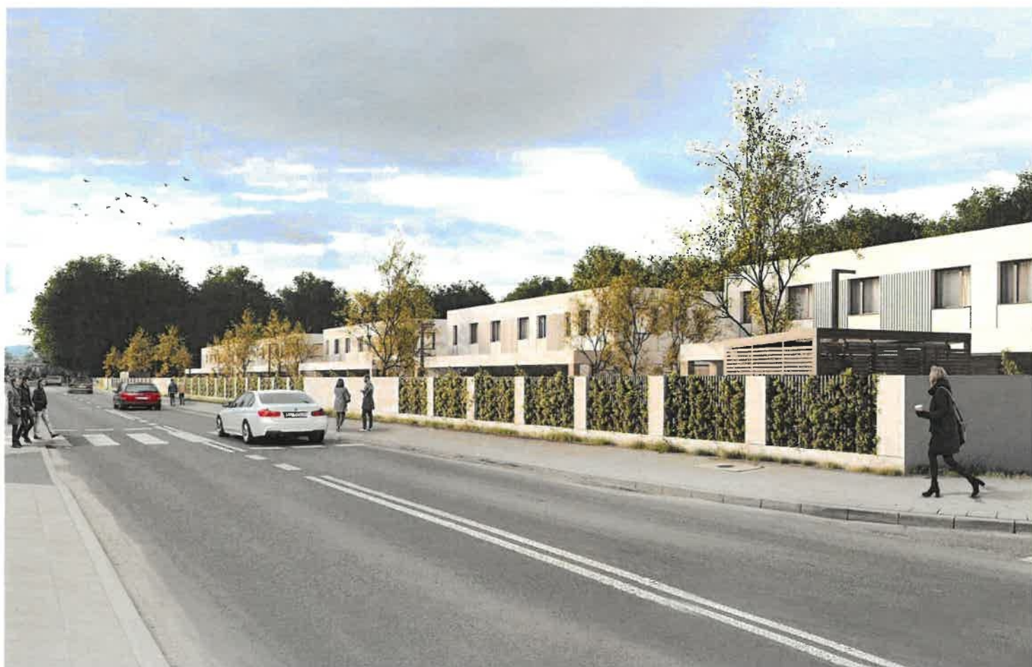
1. Widok od południowego-zachodu, skrzyżowania ul. Przylesie z ul. Gajcego
