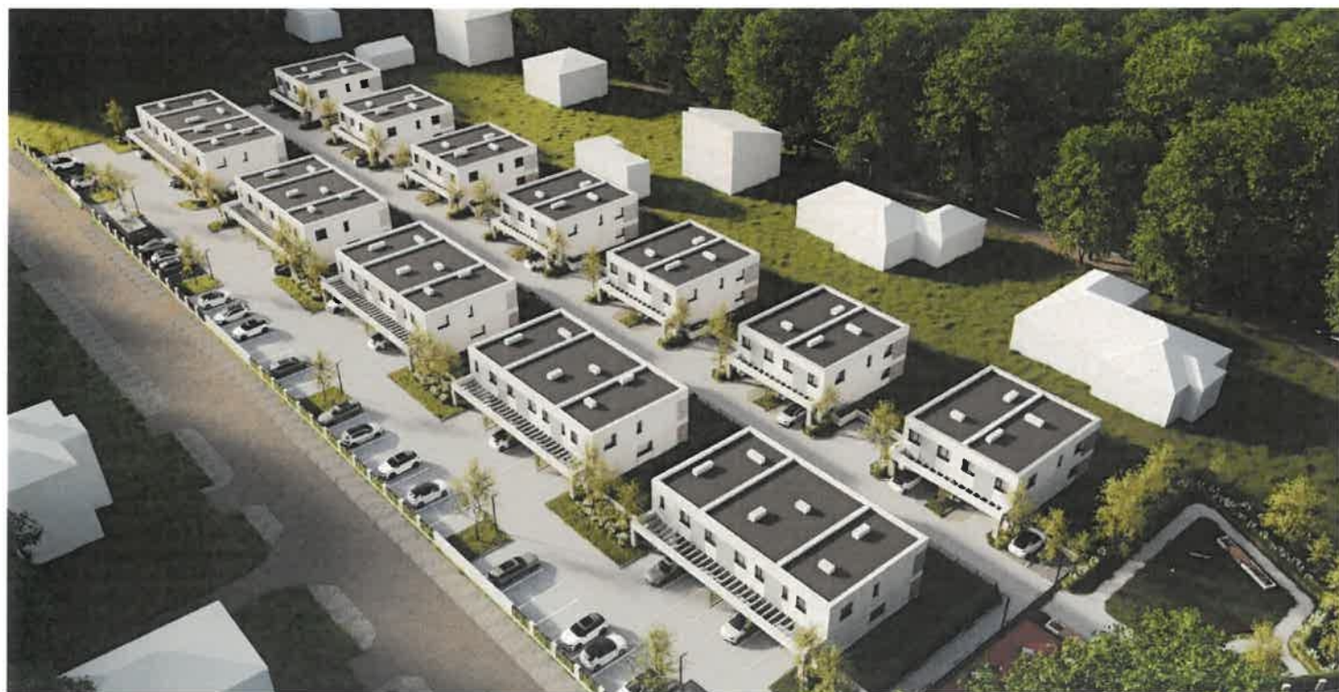
Widok z lotu ptaka w kierunku północno-wschodnim
