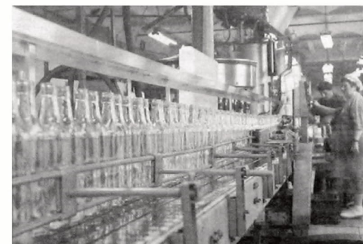
HAŁA PRODUKCYJNA BUDYNKU GŁÓWNYM Z LINIĄ TECHNOLOGICZNĄ - STAN Z 2006
