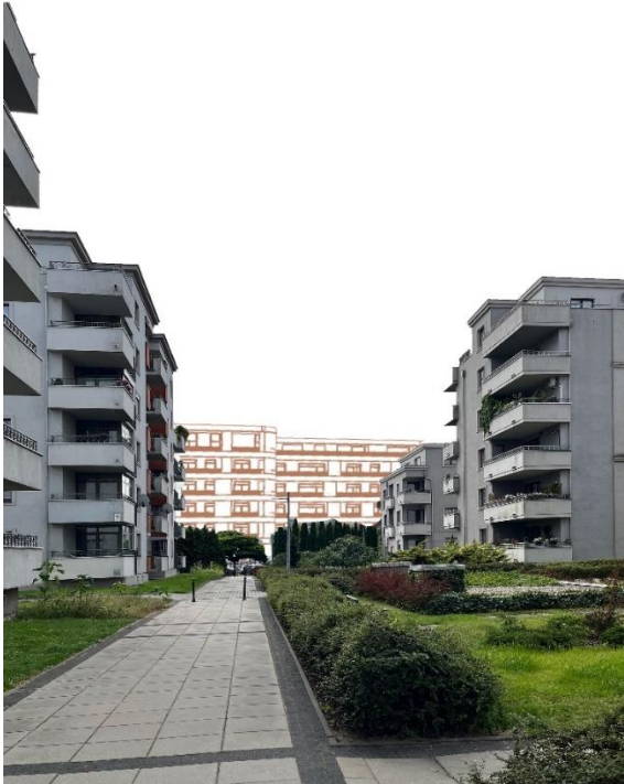
Widok 5 – widok w kierunku południowym z ulicy Tylnej 8b (wnętrze kwartału)
