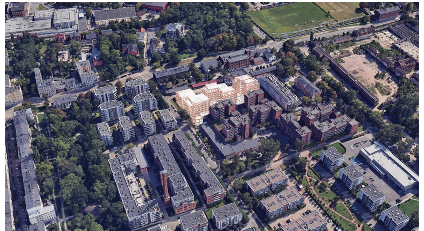
Widok z lotu ptaka w kierunku południowo-wschodnim
