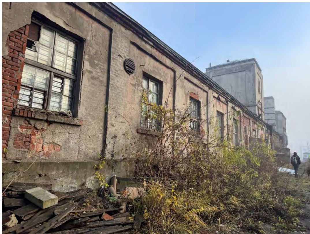
Rysunek 5 Widok ściany południowej hali szedowej
