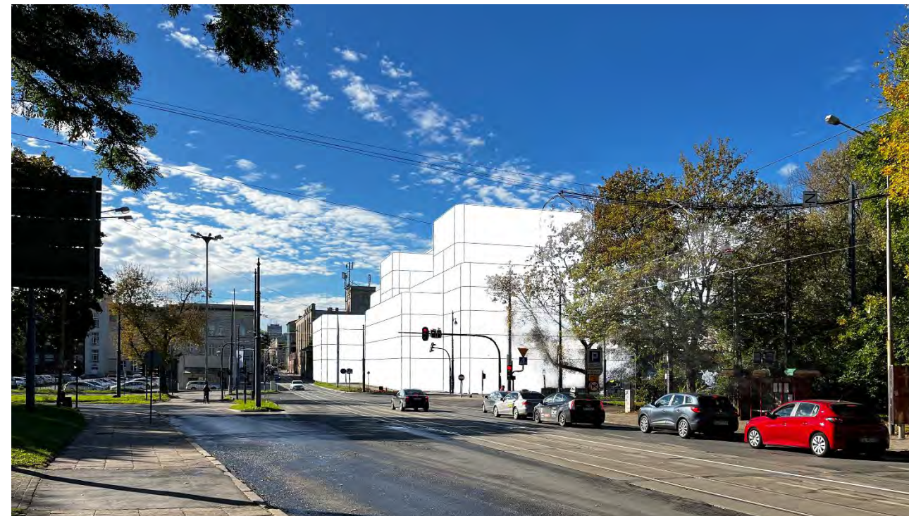
Widok 14 ul. Franciszkańska w kierunku południowym
