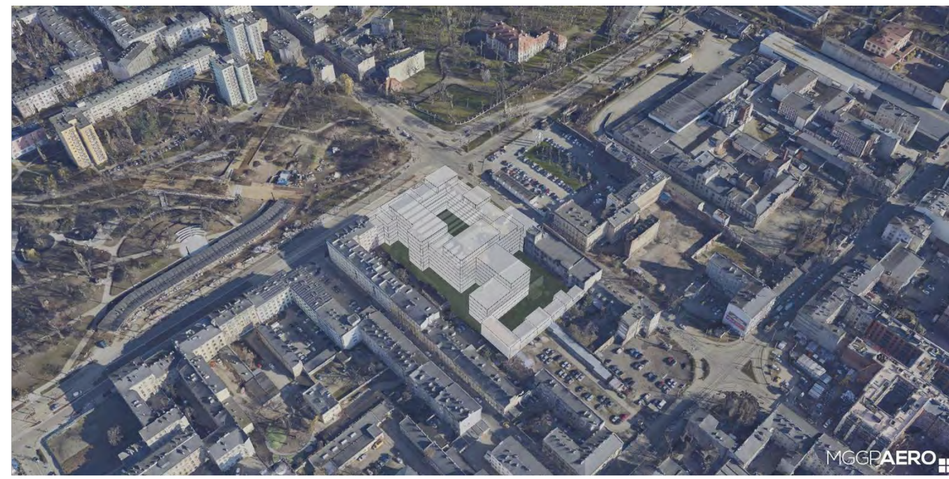
Widok z lotu ptaka w kierunku północno-wschodnim
