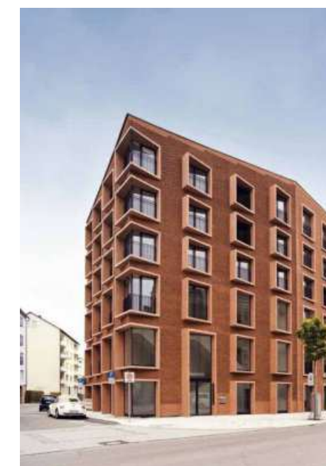
Budynek biurowo-mieszkalny Neuwog, Neu-Ulm, Niemcy arch. Fink + Jocher
