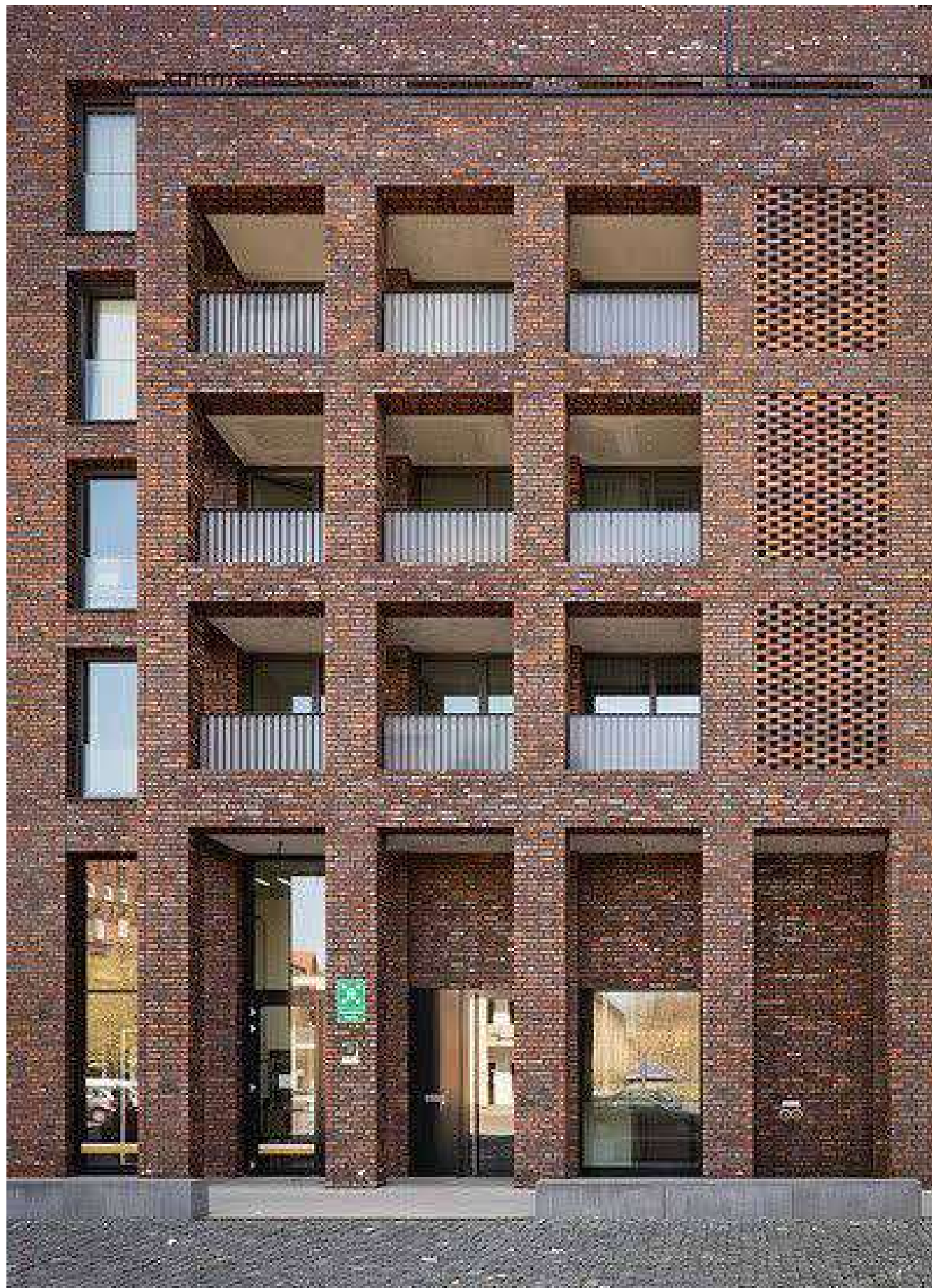
Budynek mieszkalno-usługowy, Klagesmarkt, Hannover, arch. KSW architekten
