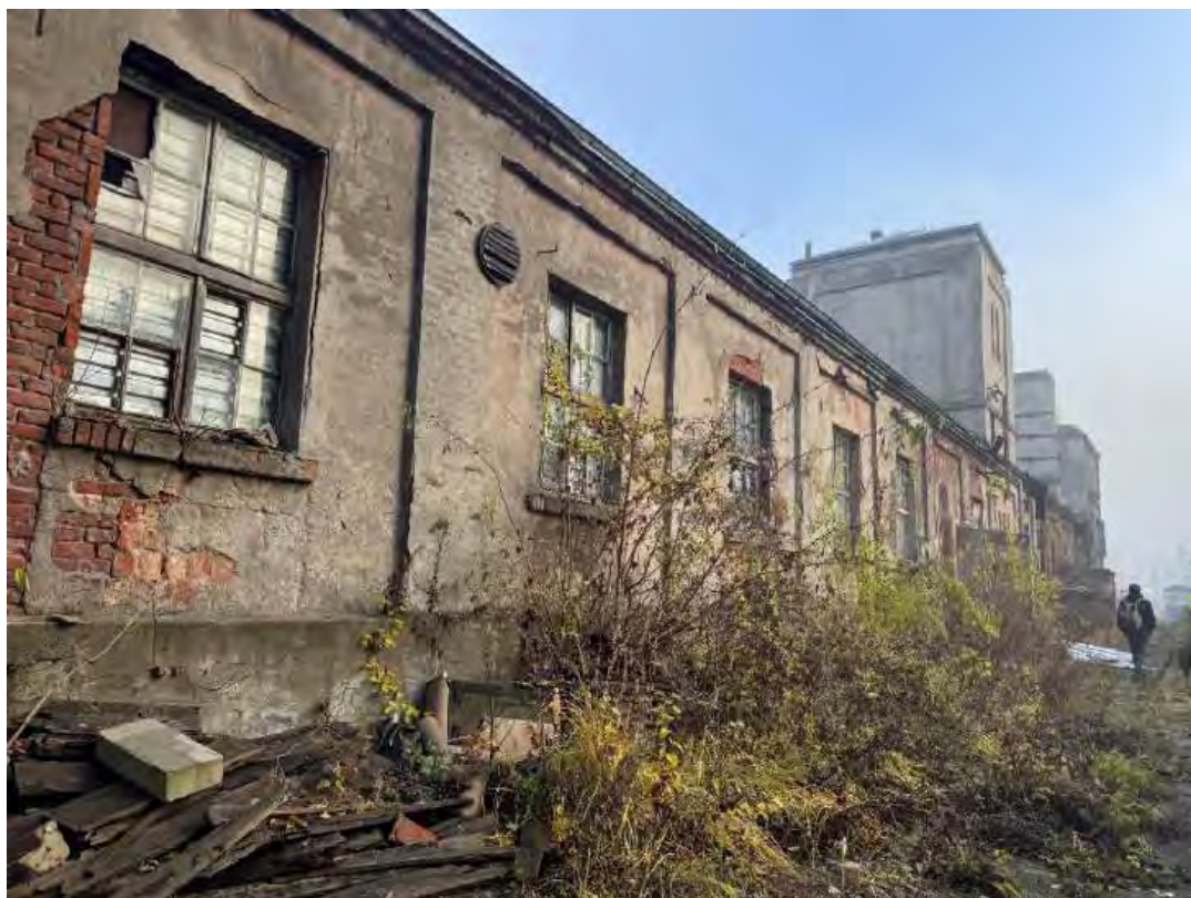
Rysunek 5 Widok ściany południowej hali szedowej
