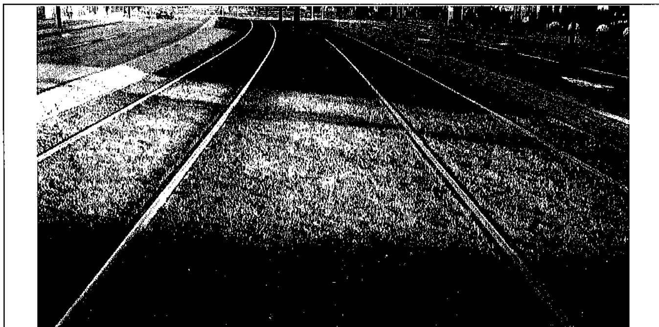
Rys. 32 Zielone torowisko – strunobetonowe torowisko bezстыkowe z matami wibroizolacyjnymi w obrębie platform i przejazdów oraz wkładkami w komorach łukowych (materiały własne)
