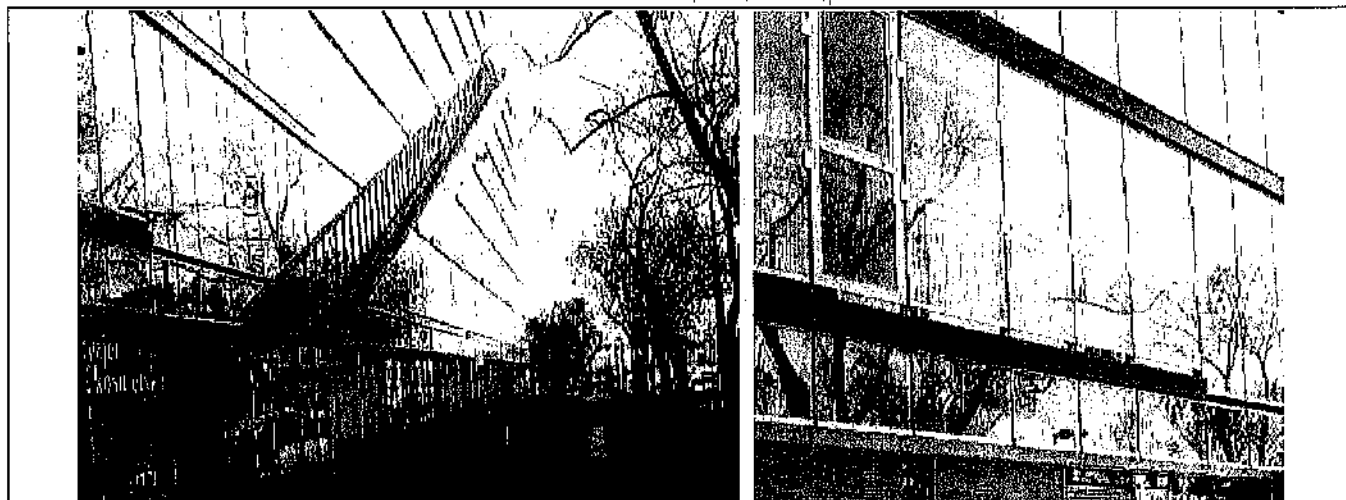
Rys. 53 Dodatkowe elewacje szklane ostatekające balkony na całej frontowej powierzchni budynku mieszkaniowo-usługowego przy ul. Banderii w Warszawie (materiały własne).
