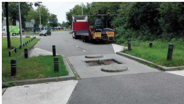
Zdjęcie 3 Rozcięcie przelotowości ulicy przy pomocy szluz autobusowej. Holandia
