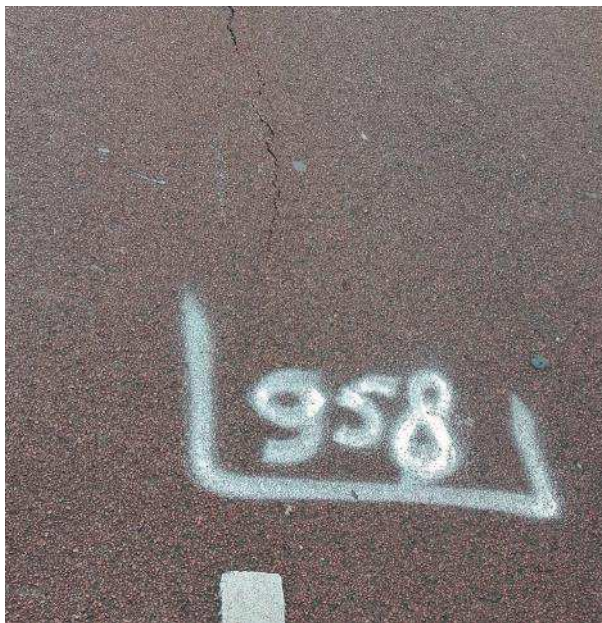
Zdjęcie 47 Oznaczenie spękania warstwy ścieralnej na drodze dla rowerów do naprawy. Holandia
