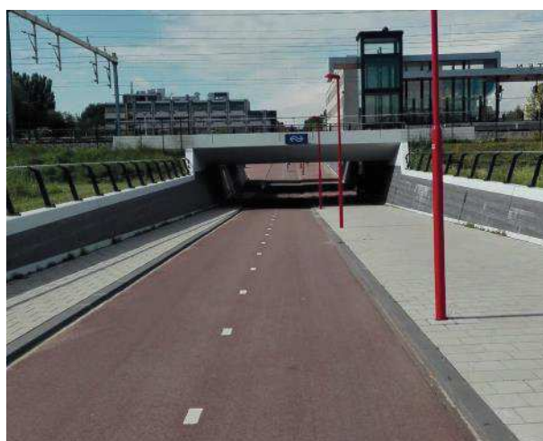
Zdjęcie 39 Wzorcowy tunnel rowerowy łączący Houten z Utrecht. Łagodny spadek, podniesiona niweleta linii kolejowej, ściany rozchylające się ku górze, świetliki, wydzielona przestrzeń dla pieszych. Holandia
