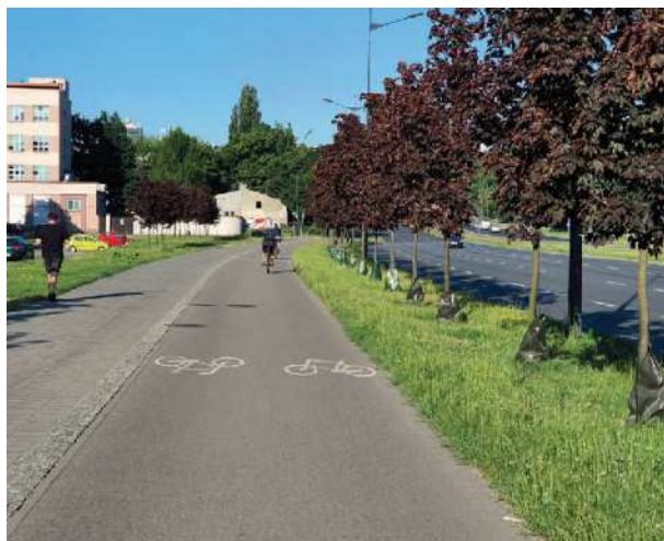
Zdjęcie 16 Przykładowa separacja drogi dla rowerów od jezdni. Łódź, Polska
