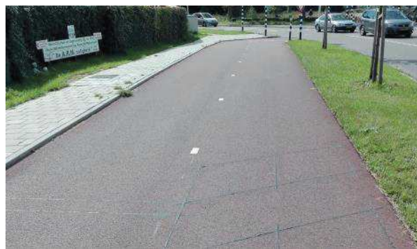
Zdjęcie 31 Detekcja rowerzystów przed skrzyżowaniem z sygnalizacją świetlną. Holandia
