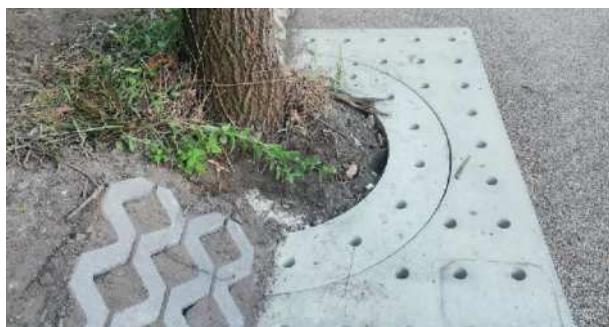
Zdjęcie 14 Płyta betonowa w ciągu drogi dla rowerów nad korzeniami drzewa. Wrocław, Polska
