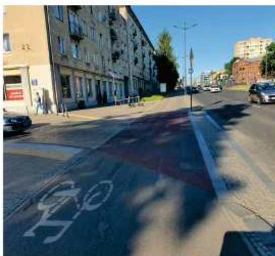
Zdjęcie 24 Droga dla rowerów z zachowaną ciągłością niwelety i nawierzchni przez drogę podporządkowaną. Łódź, Polska
