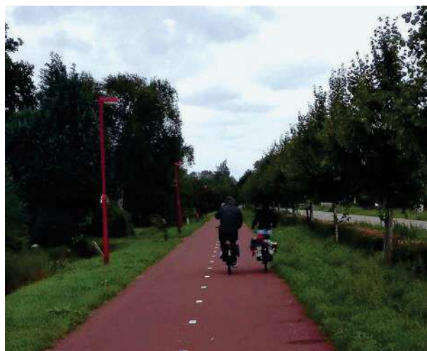
Zdjęcie 41 Oświetlenie drogi dla rowerów. Utrecht, Holandia
