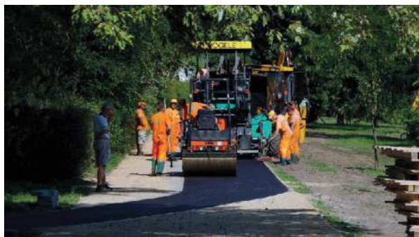
Zdjęcie 13 Rozkładanie warstwy ścieralnej przy wykorzystaniu rozścielacza. Łódź, Polska
