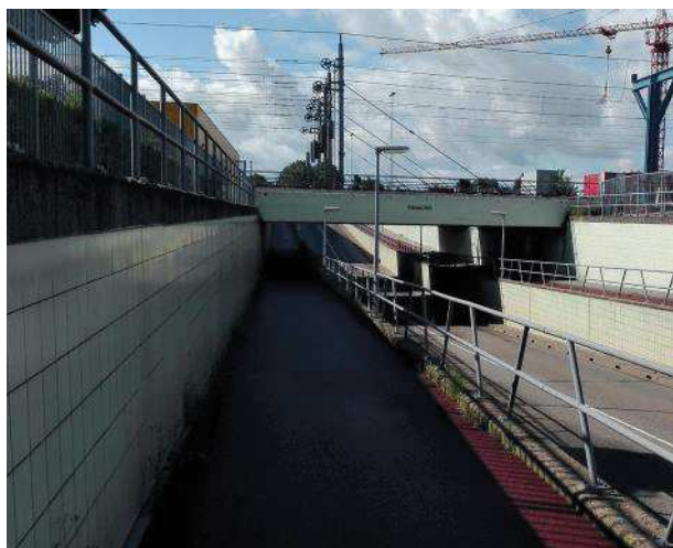
Zdjęcie 38 Niweleta drogi dla rowerów prowadzona powyżej niwelety jezdni. Amsterdam, Holandia
