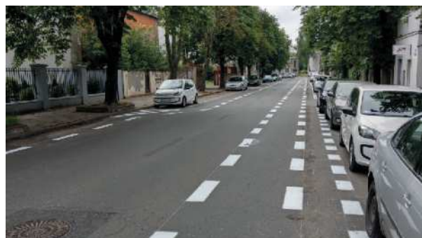
Zdjęcie 9 Pas ruchu dla rowerów z zachowaniem bufora od parkowania równoległego na strefę otwieranych drzwi. Łódź, Polska
