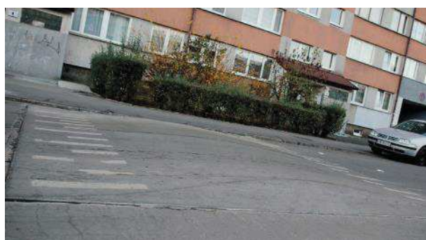
Zdjęcie 6 Wyniesiona powierzchnia sinusoidalna przyjazna dla rowerzystów. Wrocław, Polska
