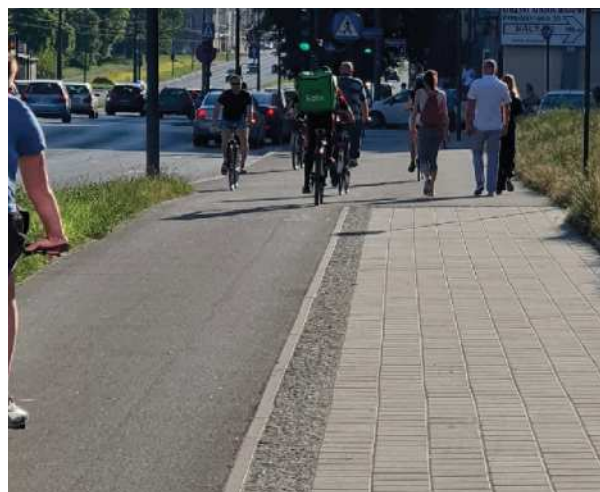
Zdjęcie 17 Seperacja drogi dla rowerów względem chodnika przy pomocy zabruku z kamienia łupanego (brak zalecanej różnicy poziomów). Łódź, Polska
