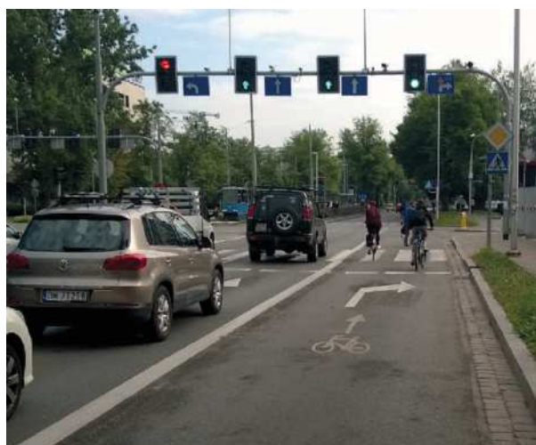
Zdjęcie 20 Prowadzenie ruchu rowerowego „na wprost” z pasa do skrętu w prawo. Wrocław, Polska
