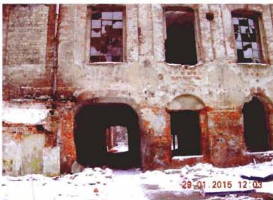
29. BUDYNEK „D” – EL. ZACH.
