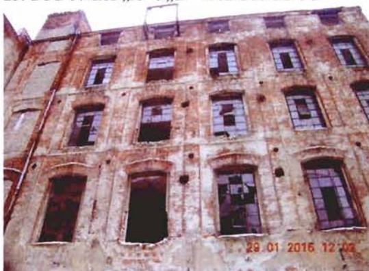
27. BUDYNEK „D” – EL. ZACH.
