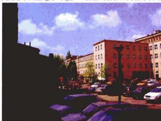
12. PASAŻ SCHILLERA – WIDOK NA UML
