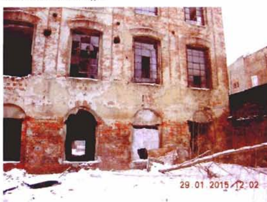
28. BUDYNEK „D” – EL. ZACH.
