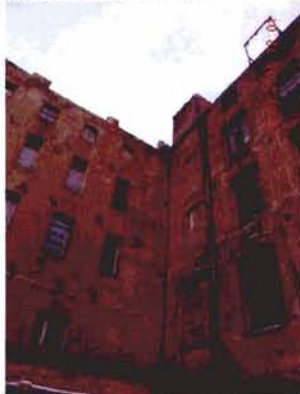
25. BUDYNEK „A” i „D” WIDOK OD PD
