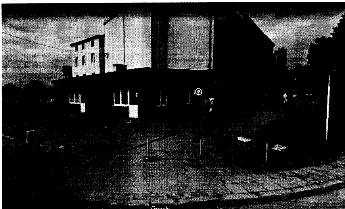
Rysunek 2 - Widok sprzed przebudowy
