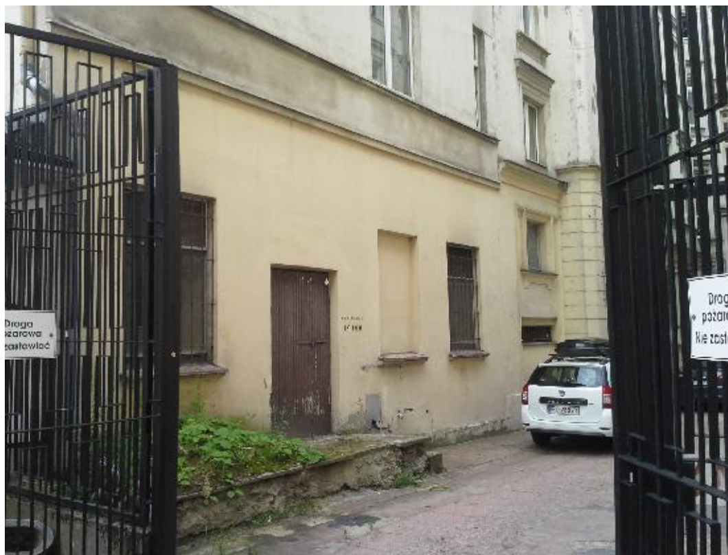
Fot. Rampa przy wejściu do adaptowanego pomieszczenia agregatu, podwórko ul. Piotrkowskiej 106 w Łodzi – stan istniejący.
