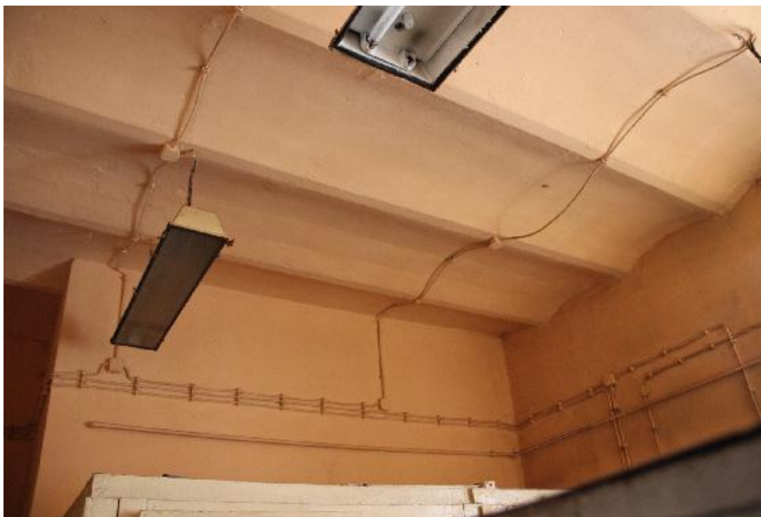
Fot. strop nad adaptowanym pomieszczeniem agregatu – stan istniejący.
