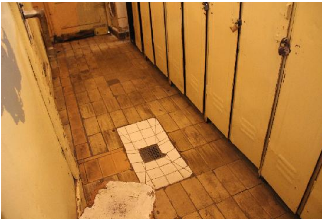
Fot. posadzka w adaptowanym pomieszczeniu – stan istniejący.
