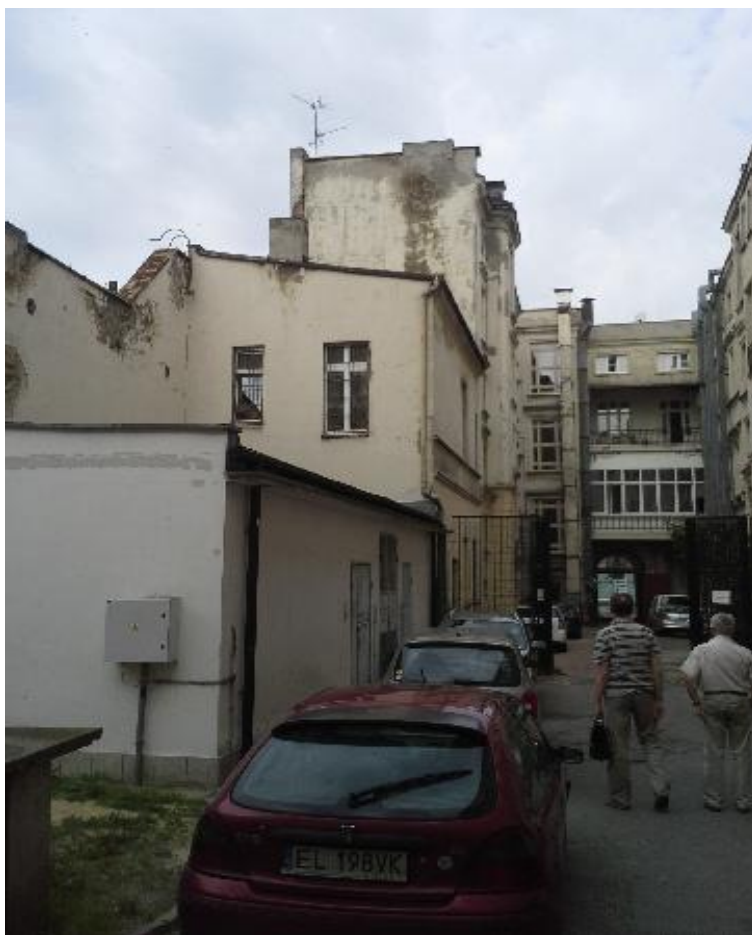
Fot. widok budynku trafostacji i dwukondygnacyjnej dobudowy do oficyny kamienicy przy ul. Piotrkowskiej 106 w Łodzi – stan istniejący.
