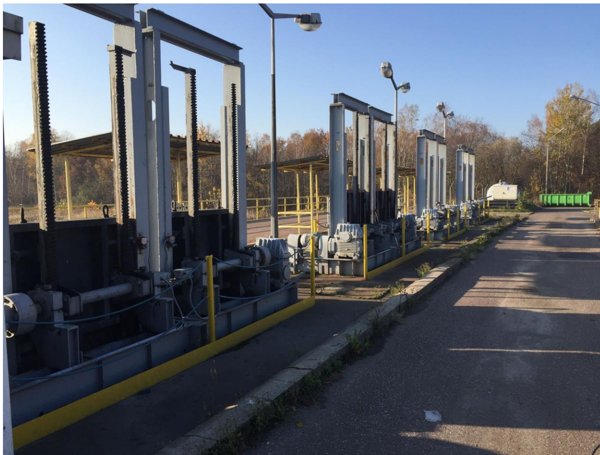
Fot. 5. Zastawki wylotowe z piaskowników do kanału rozdzielczego na OWS.
