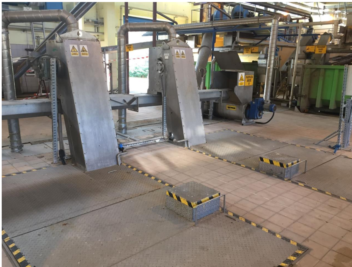
Fot. 1. Hala krat - kraty linii nr 7 i 8 wraz z prasopłuczką skratek z linii nr 5-8.
