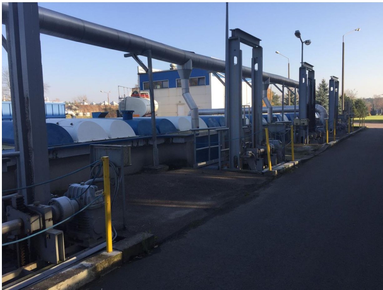
Fot. 4. Zastawki wlotowe z głównej komory wlotowej do hali krat.
