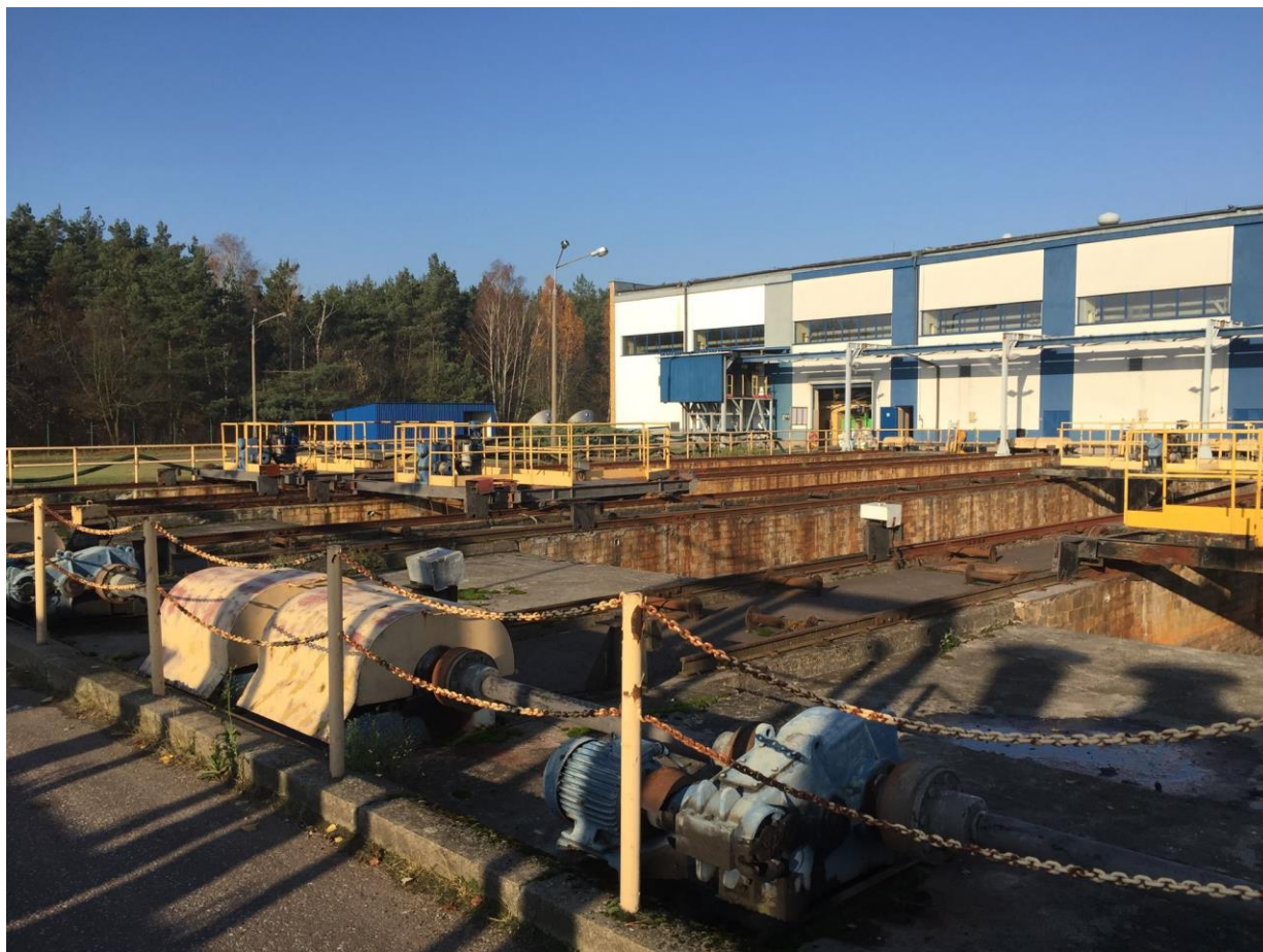
Fot. 3. Piaskowniki – widok od strony zachodniej.
