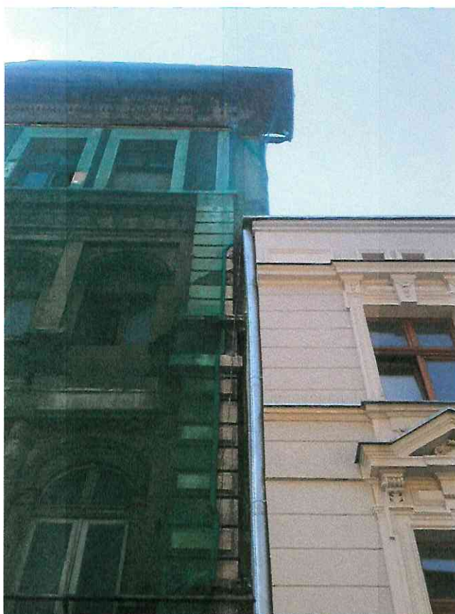
Zdj. 8. Szczyt wymurowany na ścianie sąsiedniego budynku (Kilińskiego 47)
