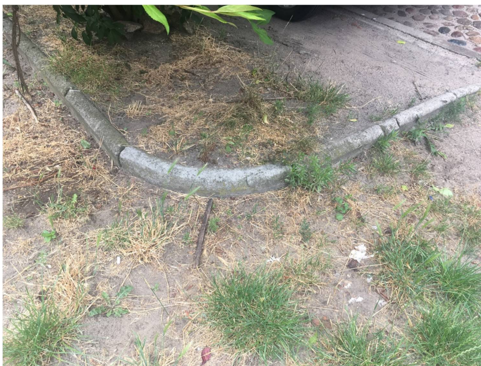
Fotografia 30– 17.07.2019r., fot. B.Andrzejczak, Obrzeże w formie półkolistej – zejście na skwer od strony północnej, ul. Srebrzyńska 87.
