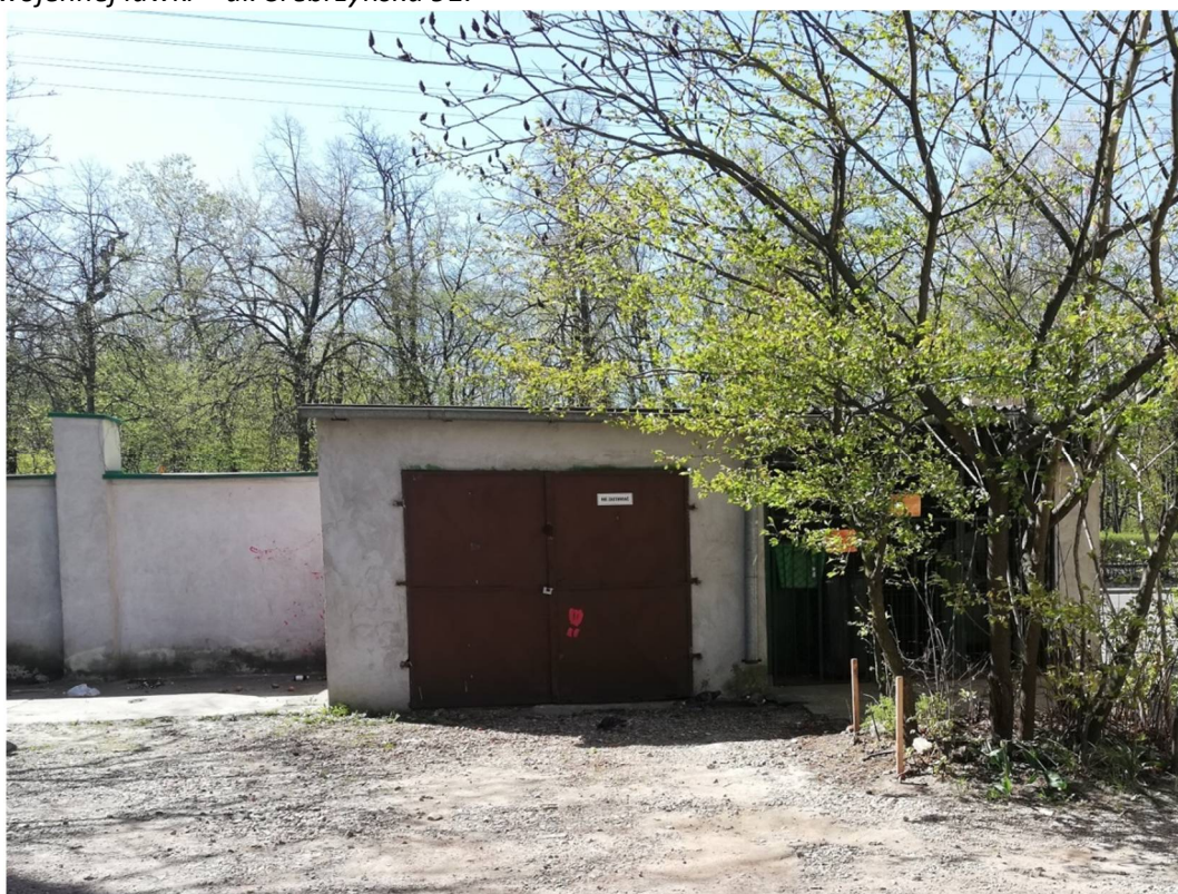
Fotografia 20– 19.04.2019r., fot. B.Andrzejczak, Budynek gospodarczy – pergola do składowania odpadów stałych przy murze – ul. Srebrzyńska 89.
