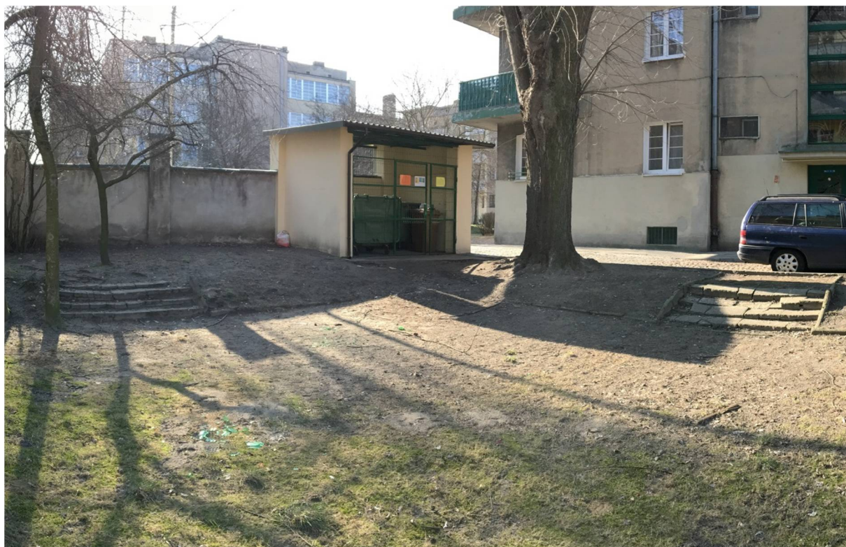
Fotografia 5 – 19.02.2019r. fot. B.Andrzejczak; Wewnętrzny dziedziniec wraz z zejściami (schody w złym stanie technicznym), ul. Daniłowskiego 5
