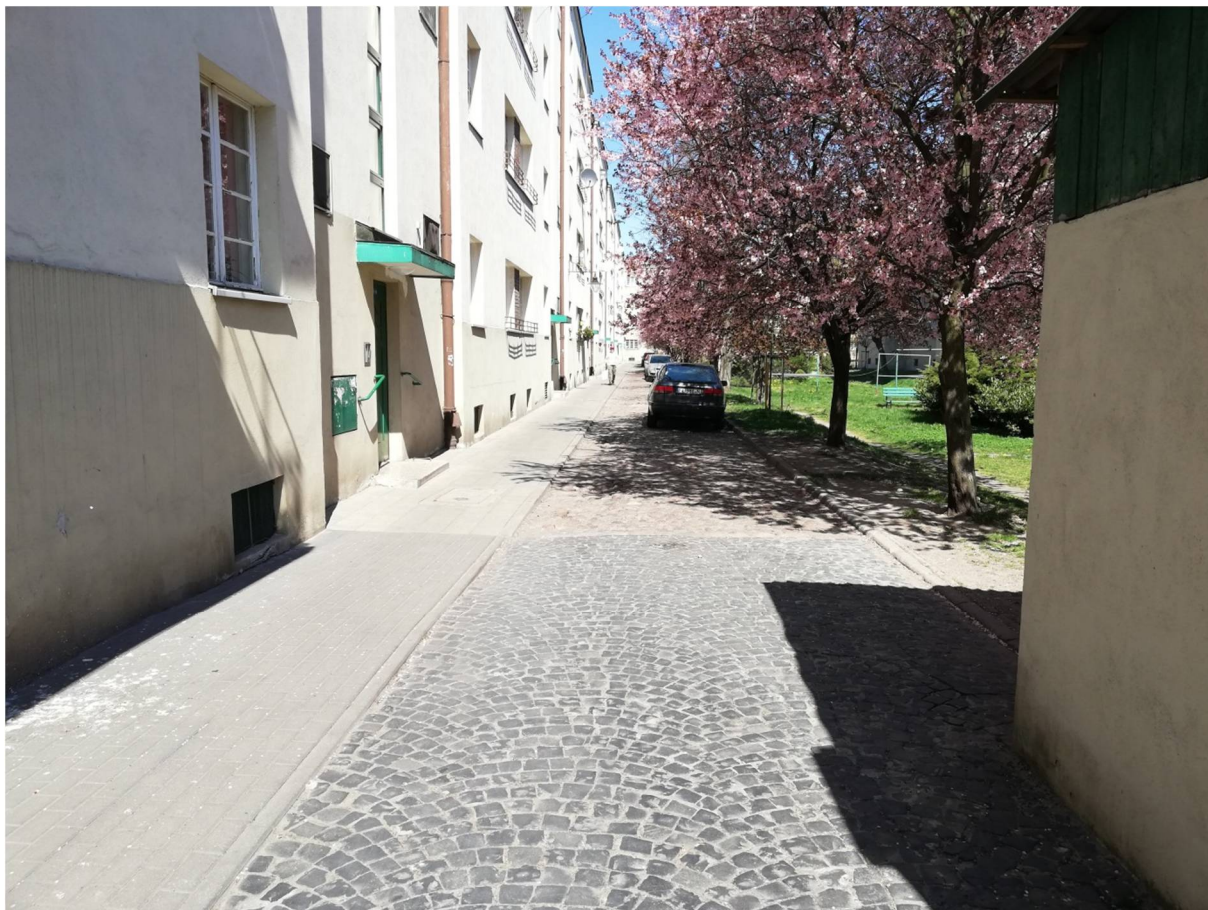
Fotografia 3 – 19.04.2019r. fot. B.Andrzejczak; Wewnętrzna brukowana uliczka wraz z utwardzeniem z kostki bazaltowej, ul. Daniłowskiego 7
