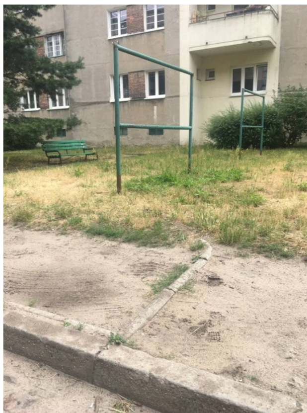
Fotografia 28– 17.07.2019r., fot. B.Andrzejczak, Obrzeże w formie półkolistej – zejście na skwer z trzepakami, ul. Srebrzyńska 87.
