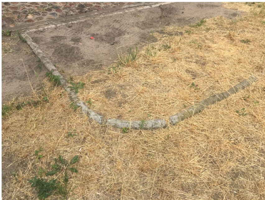
Fotografia 29– 17.07.2019r., fot. B.Andrzejczak, Obrzeże w formie półkolistej – zejście na skwer od strony północnej, ul. Srebrzyńska 87.
