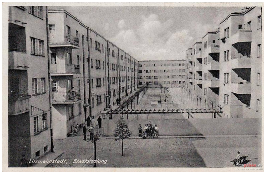
Fot. nr 1 – Zdjęcie archiwalne, widoczne dwa szpalery drzew: przy drodze wewnętrznej oraz pod ryzalitami.
