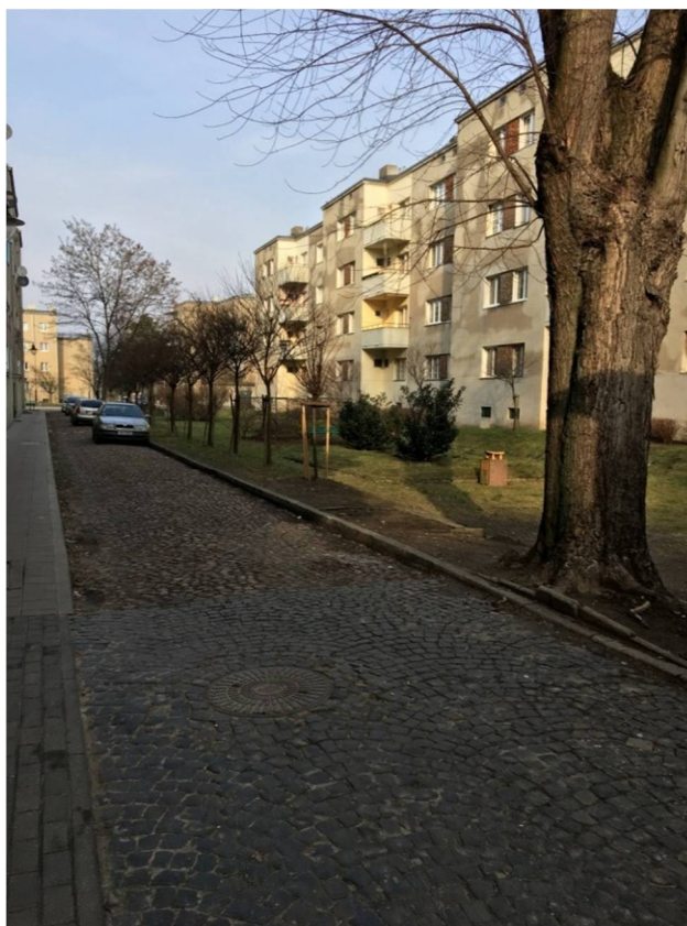
Fotografia 2 – 04.03.2019r. fot. B.Andrzejczak; Wewnętrzna brukowana uliczka wraz z utwardzeniem z kostki bazaltowej, ul. Daniłowskiego 5
