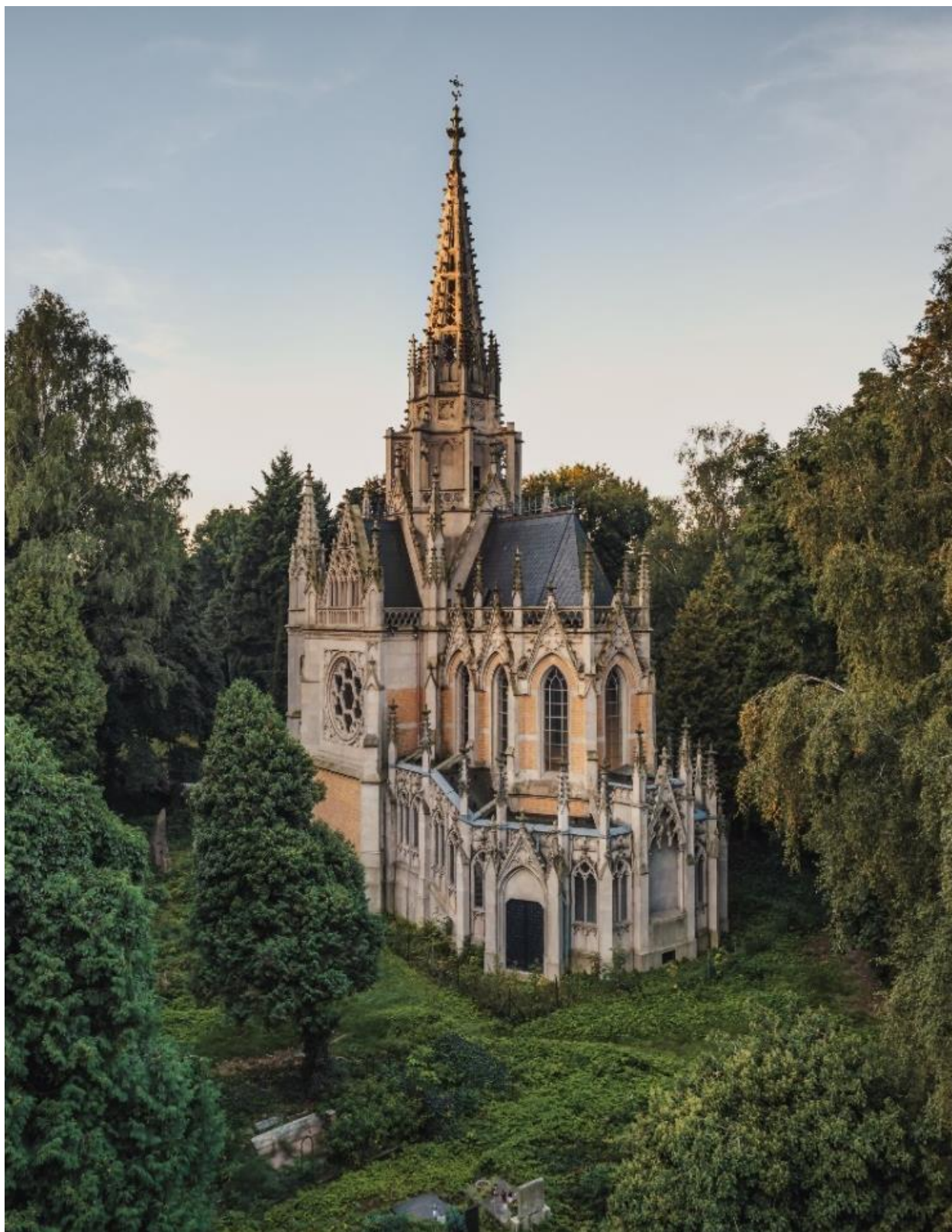
Kaplica Scheiblera na Starym Cmentarzu, ul. Ogrodowa 43
