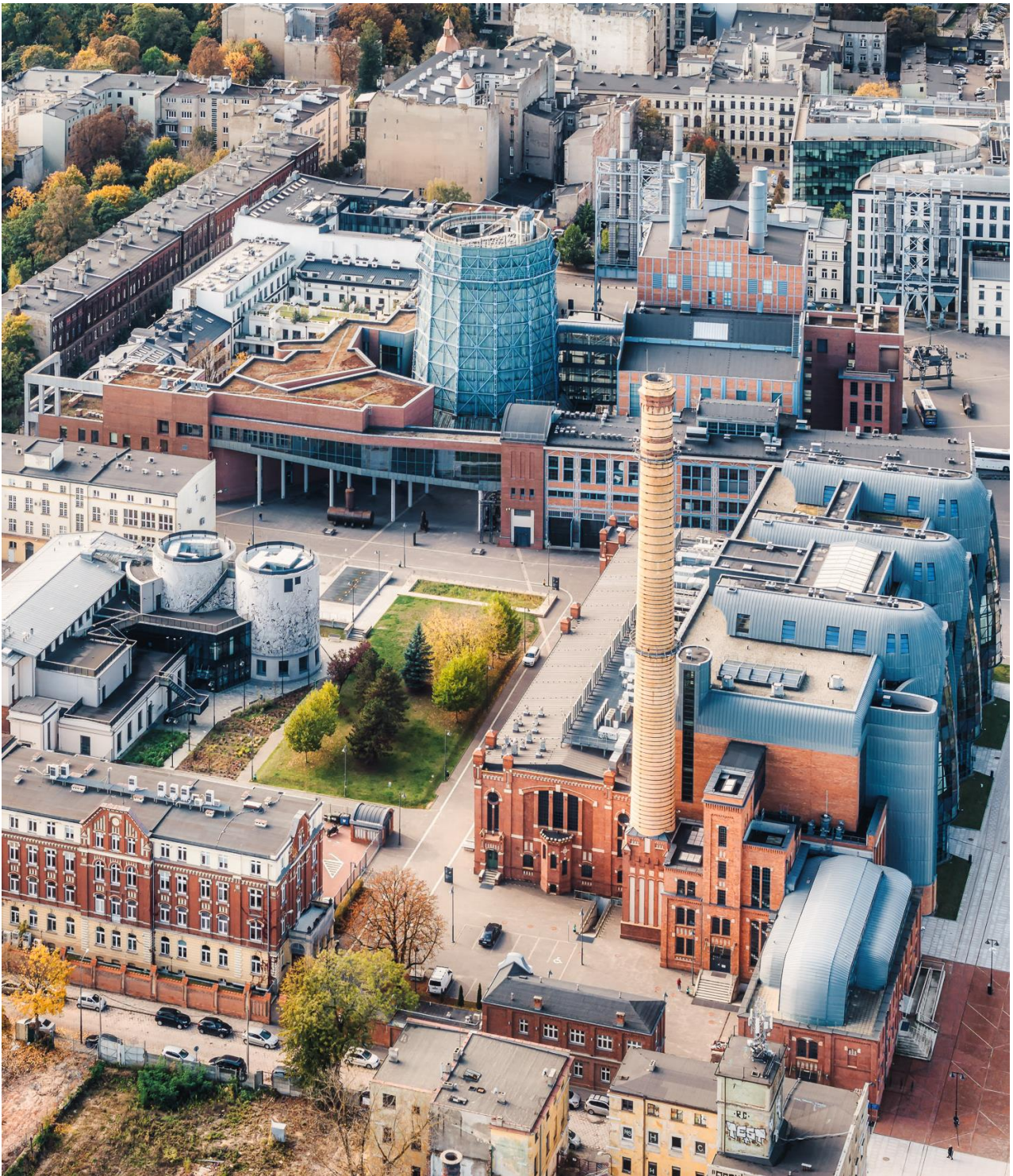
Elektrociepłownia 1 - EC1, ul. Targowa 1/3
